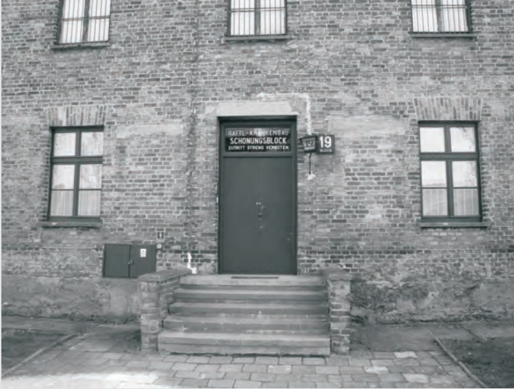
Block 19, der Schonungsblock
